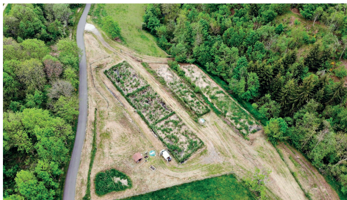
Vue aérienne de la station actuelle (source MAGE)
